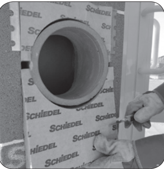
35. Az előlapot a megfelelő méretre levágjuk.
