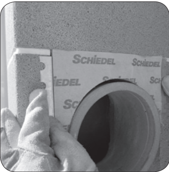
36. Az előlapot a szögvasak segítségével rögzítjük.
