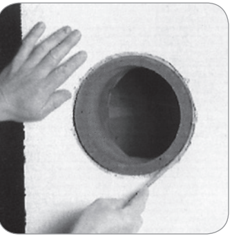
37. Rabicháló felhelyezése után a vakolást elvégezzük. A vakolat megszilárdulása előtt a füstcső-csatlakozó körül – szöggel – elválasztó hornyot alakítunk ki a samottcső és a vakolat között.
